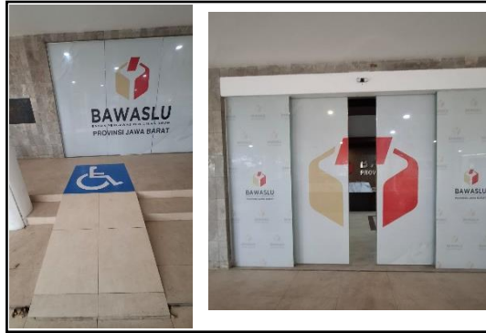
Gambar 27. Akses Jalan Landai, Simbol ISA dan Pintu Otomatis
